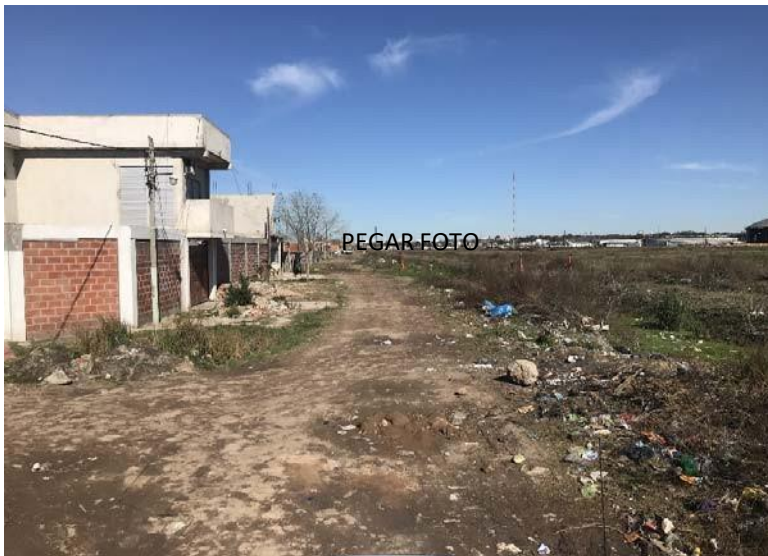
FOTO SENTIDO DE AVANCE – FECHA: JULIO 2020
